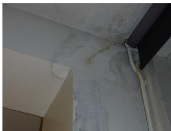
Figur 3: Riss søyle/bjelke
