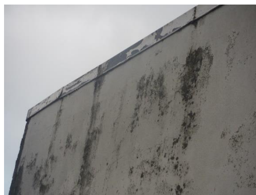
Figur 4: Potensielt skjulte betongskader
